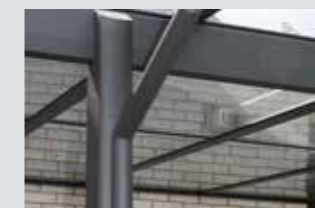
TerraFlex in Dachfarbe beschichtetes Aluminiumfallrohr
