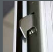
Mehrfachverriegelung mit Riegel/Falle und 2 Schwenkriegel
